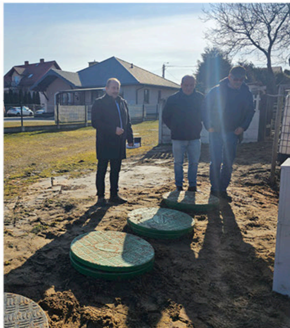
Budowa w miejscowości Olszówka
