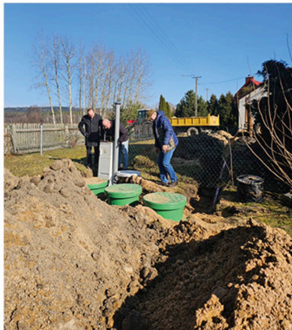
Budowa w miejscowości Dobrzeszów
