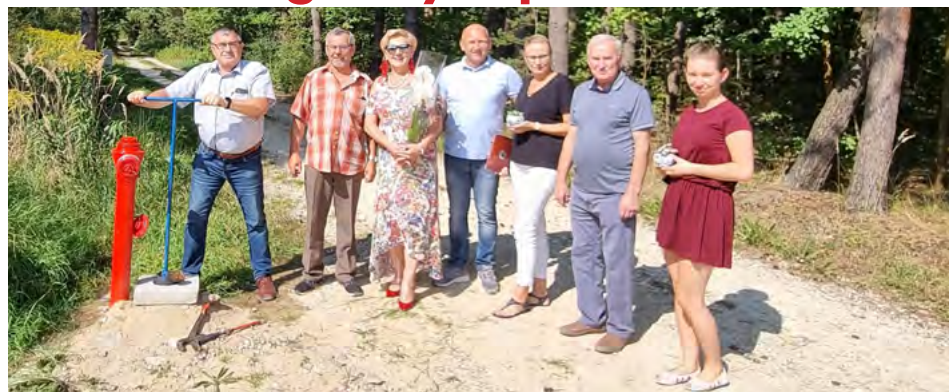
Sukcesywnie rozwijana sieć wodociągowa na terenie Miasta i Gminy Łopuszno
