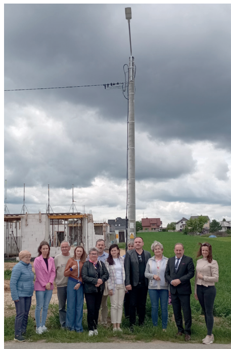
Odbiór oświetlenia przy ul. Żwirowej
