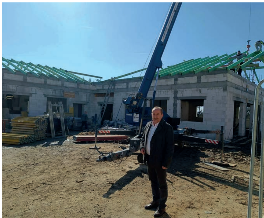
Plac budowy w Łopusznie
